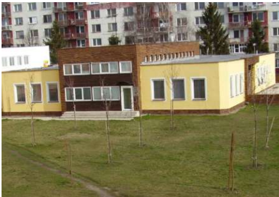
Pohľad na objekt DC1 zo strany prístupu na Riaditeľstvo OSS
