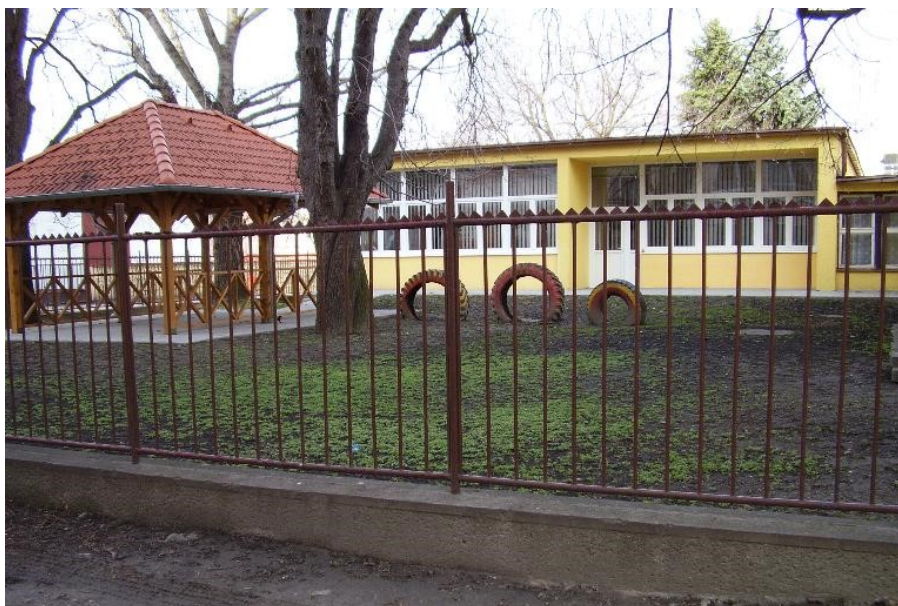
Čiastočne rekonštruovaný objekt a areál DSSPD
